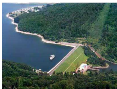
Obr. 3 Vodná elektrárň Domaša
